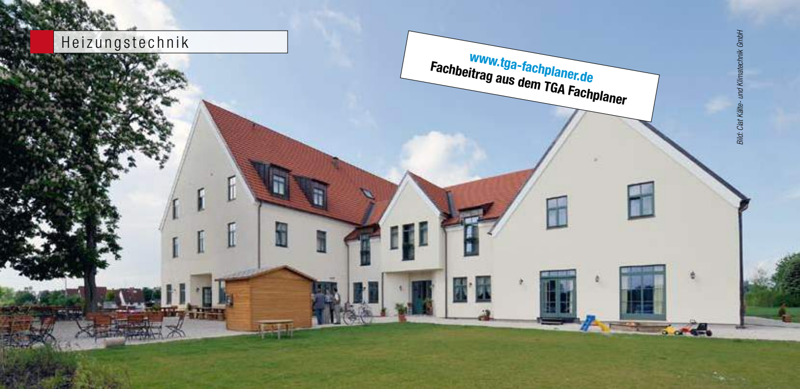
Neubau der Brauereigaststätte St. Afra im Felde mit Tagungshotel und Biergarten.
