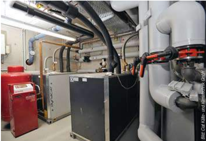
Weil die TGA-Planung erst nach dem Rohbau erstellt wurde, musste die Wärmepumpenanlage unter beengten Verhältnissen installiert werden...
